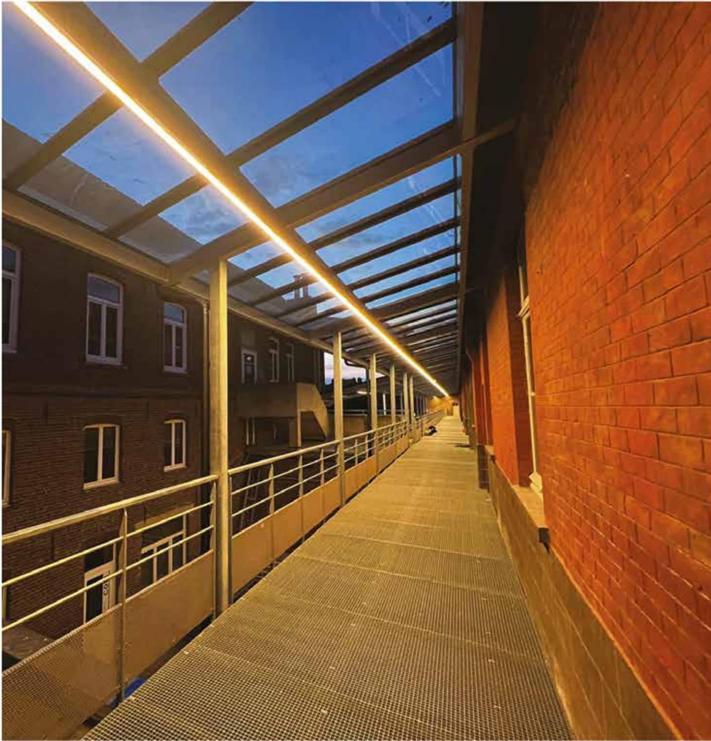
Collège privé Saint Jacques, 58 rue de la sous-préfecture, 59190 Hazebrouck, France Lighting Design crédit photo Sceneo Nord, Wasquehal, France
